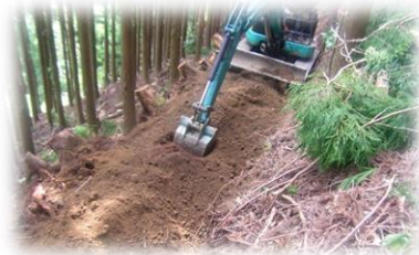
間伐作業道開設作業
