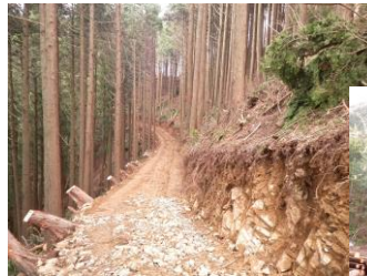
奥足谷作業路開設
